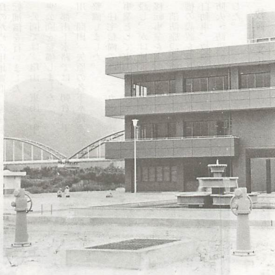
朝田浄水場の管理本管と樺野川にかかる第1号水管橋
