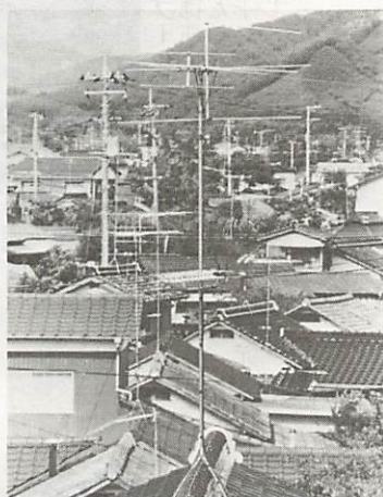
屋根の上に取り付けられているテレビアンテナ。台風を受けやすいので特に注意が必要です
