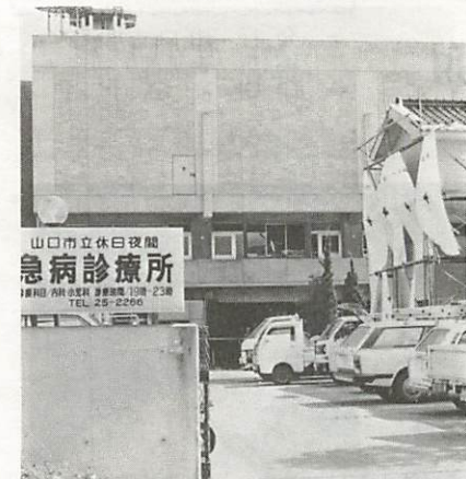
建設中の休日夜間急病診療所外科部門
