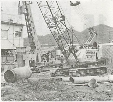
工事が始まった社会福祉センター
