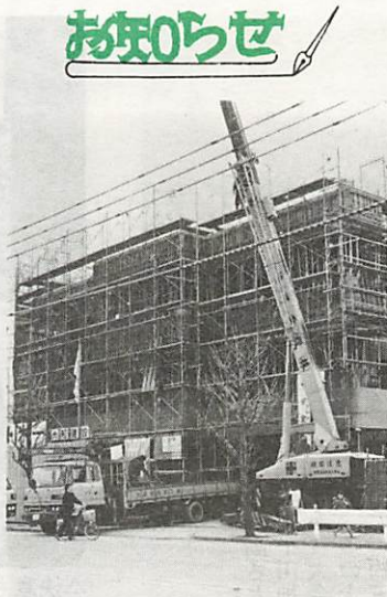
「しらさぎ会館」は、鉄筋コンクリート造り4階建て、5月末に開館の予定です
