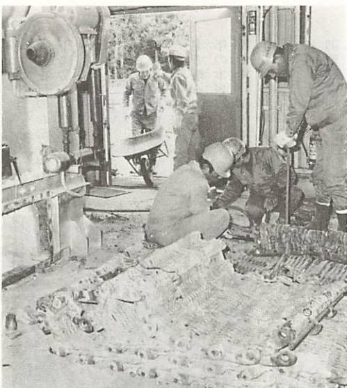
焼却炉のオーバーホール風景。焼却炉の手前に出されているのは、炉の中にごみを送り込む装置です
