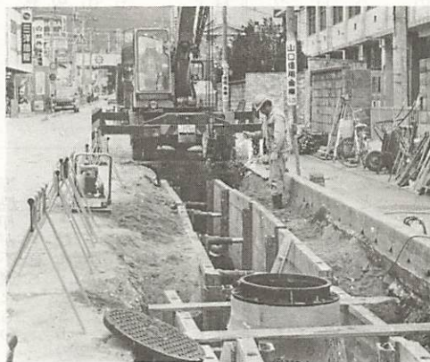
道場門前付近で進められている下水道管理設工事
