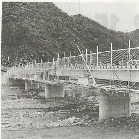
仁保川に架かる一渡瀬橋。車道幅は6m。橋の長さは、78.6mで、完成予定は3月上旬です
