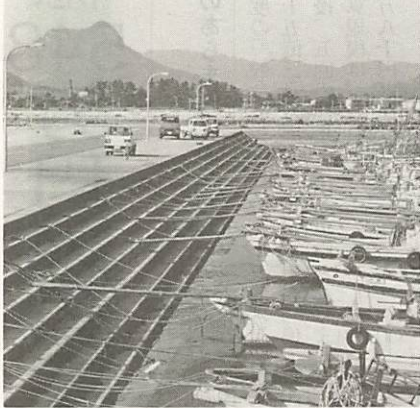
整備が進む山口漁港。59年度は、防波堤の前面に消波工を設置します
