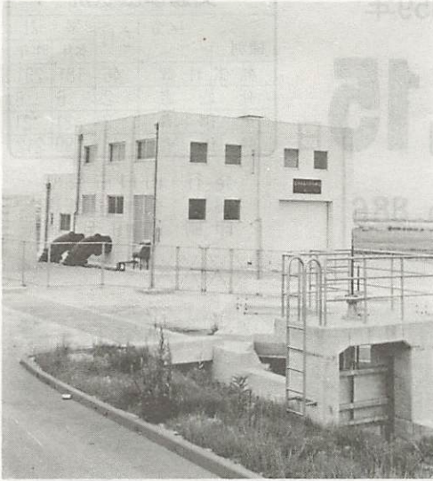
完成した第2排水機場。水田の高度利用と農業経営の安定が図られると共に、防災の面でも大いにその効果が期待されます
