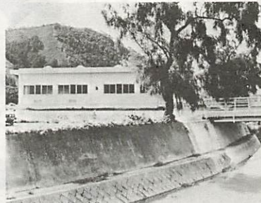
電気設備工事が待たれる公共下水道一の坂川中継ポンプ場
