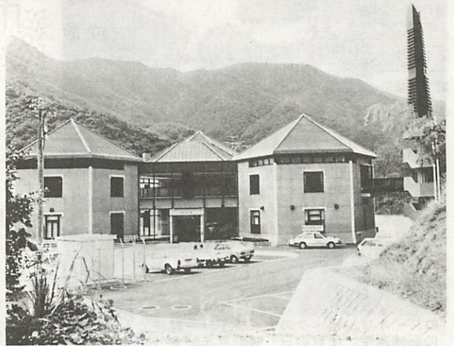
「キノコ」をイメージ化して建設した山口ふれあい館。館は、鉄筋コンクリート2階建てで、本館建築費は2億700万円（総事業費は約5億1038万円）。将来、この館から21世紀の森へ通じる道路も整備されます
