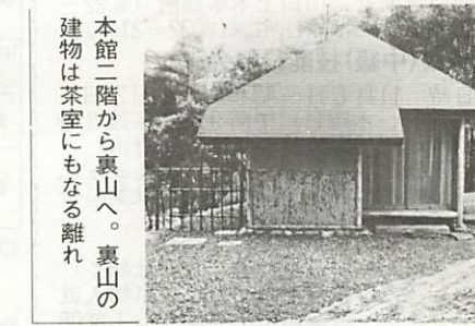
本館二階から裏山へ。裏山の建物は茶室にもなる離れ
