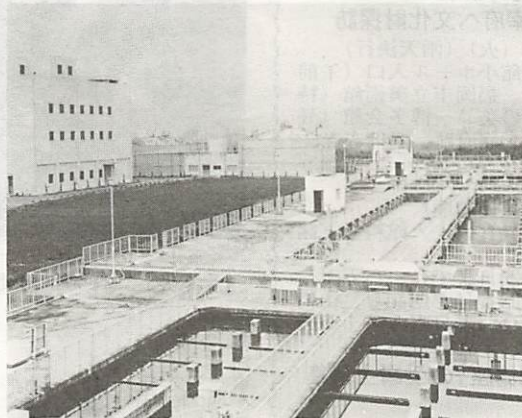
浄水センター。60年度は水処理施設を増設します
