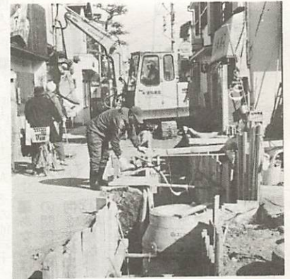
亀山町付近での下水道管理設工事
