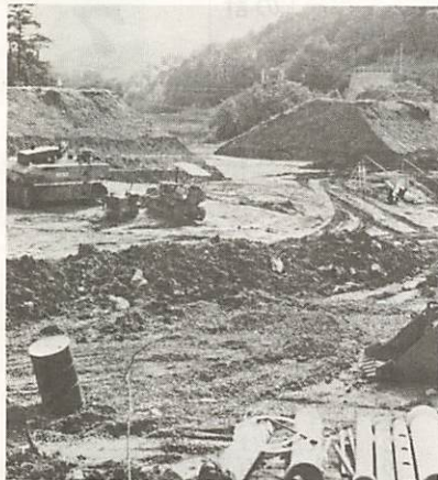
陶整理ため池(写真)や佐山河原谷ため池を改良するほか、嘉川鮎ヶ谷ため池を調査、設計します
