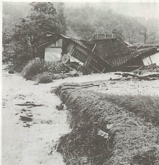
昭和47年7月、市内を襲った集中豪雨。豪雨に備えて、川やがけの位置、地質、地盤の高さなどを知っておき、被害を最小限に止めましょう
