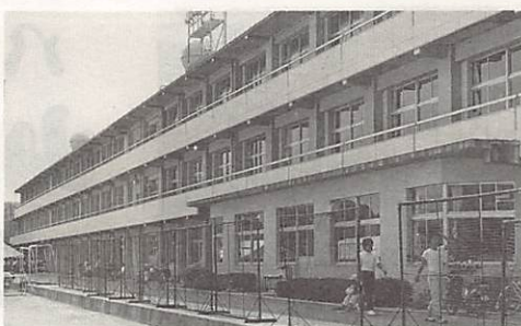
鉄筋コンクリート造り三階建ての鴻南中学校新校舎
