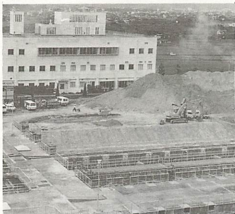
汚水処理施設の増設工事が進む、浄水センター
