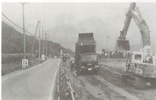
県道山口大道線の拡幅改良工事(小鯖地区)
