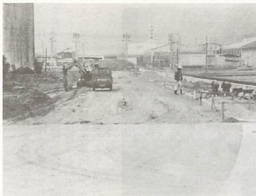
整備が進む、都市計画街路・東山通り下矢原線(旭通り二丁目)
