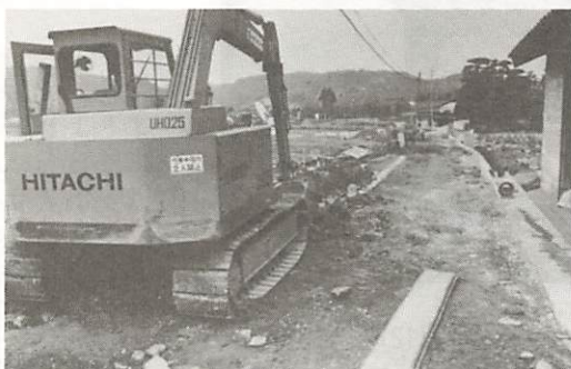
市道小路須川前2号線の道路改良工事(佐山地区)
