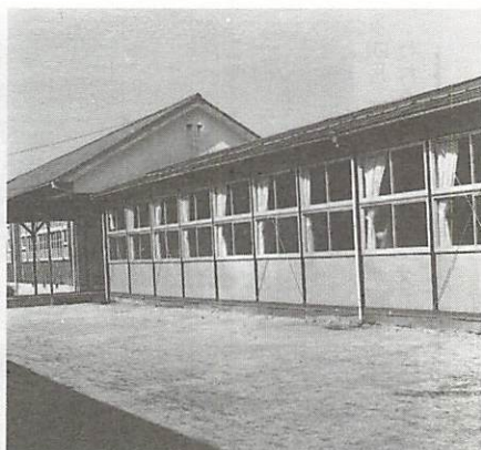
普通教室が増改築される湯田小学校
