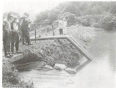
洪水時の緊急放水に効果的なサイフォン
