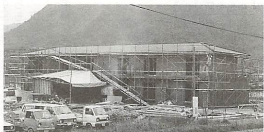
建設工が進む大歳公民館・出張所(写真上)と宮野下田市営住宅(写真下)
