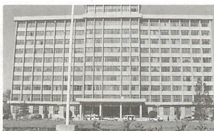
11階建ての立派な済南市庁舎
