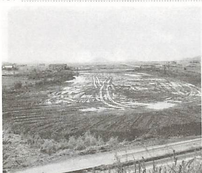
ウイングエイティイやまぐちの中核施設となる山口総合センター(仮称)の建設用地
