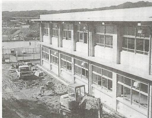
興進小学校の新校舎。運動場に面した外壁には模様をつけています(2月13日撮影)
