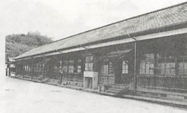
改築が予定される湯田小校舎
