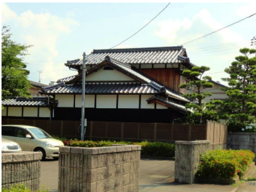
屋根に無彩色の日本瓦が使用されており、伝統的で風格のあるデザインとなっています。
