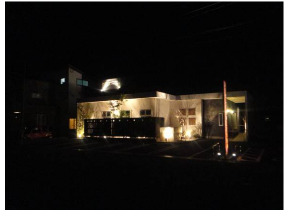
照明器具周辺にルーバーを設置し、光の量が過剰にならないよう配慮されています。
