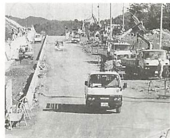
御堀平井線の道路整備
