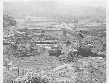
仁保才田工区でのほ場整備
