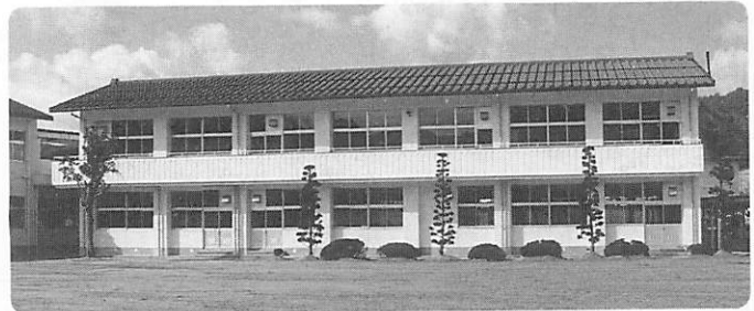
▲新しい八坂中特別教室棟 青空にさび色の屋根がはえて
