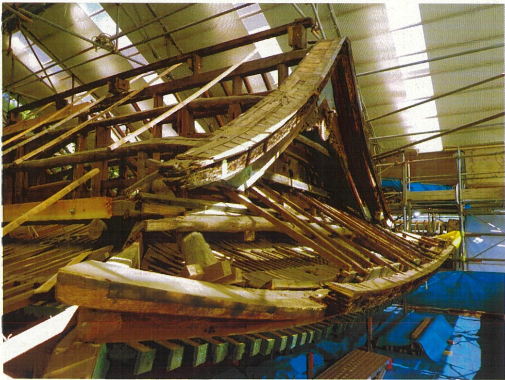
修理工事の様子
