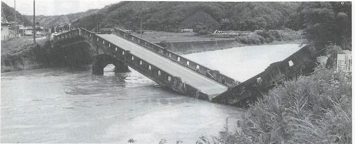
橋脚が流れ、折れまがった慶福橋
