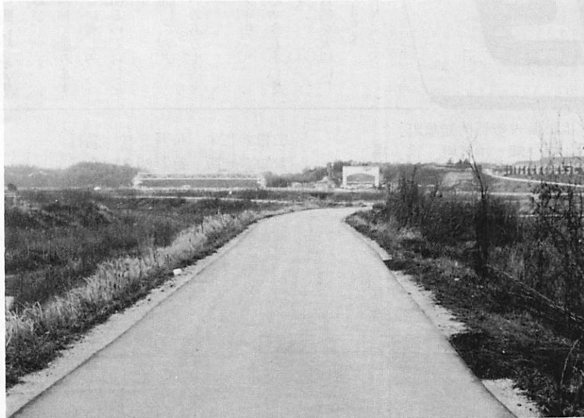
①土路石川沿いの町道を舗装
