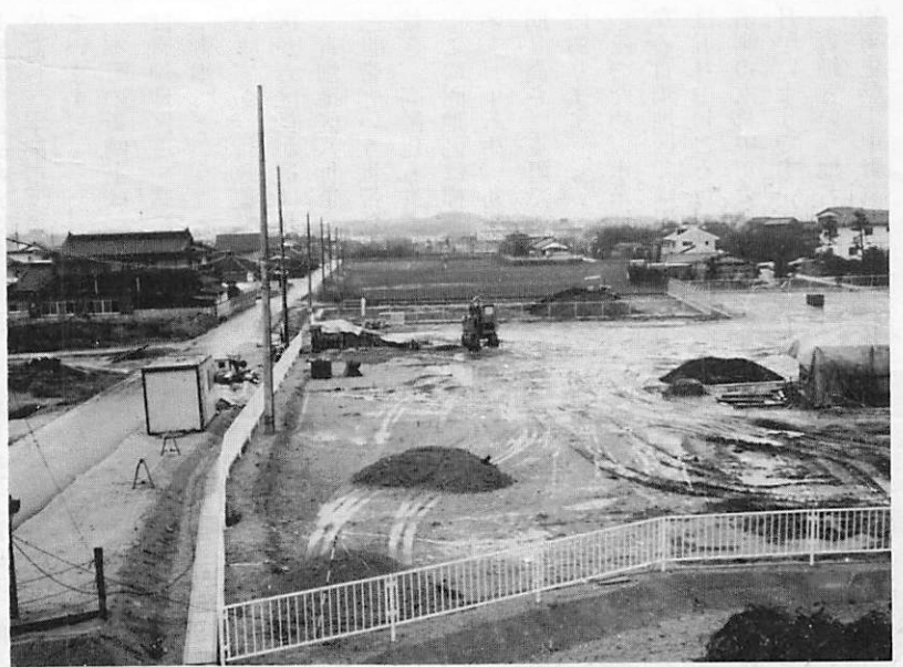
②砂郷地区の道路舗装と児童公園の建設
