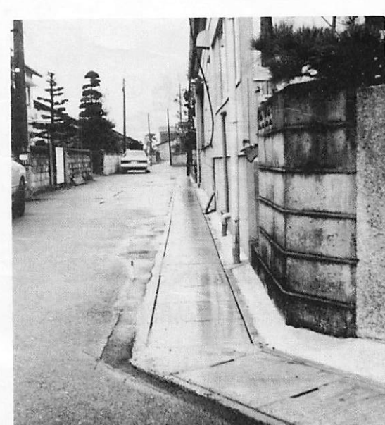
③縄田地区の水路改修
