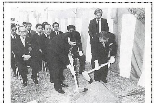
アルメタックス(株)と関西アルミ製造(株)の山口工場、建設着工
