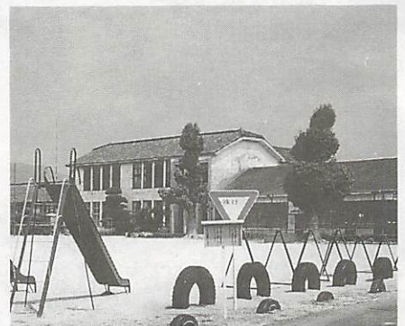
嘉川小学校校舎（木造老朽校舎・2,316㎡）
