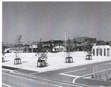
みんなの憩いの場も、もうすぐ完成
