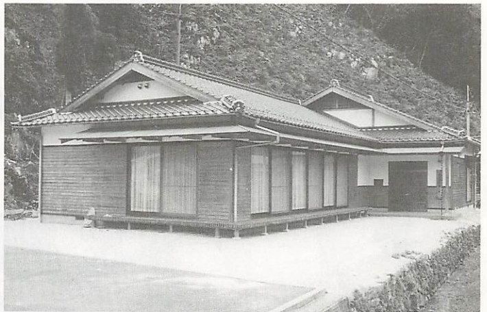
旧過疎法のもとで、900万円の過疎債を充当して完成した岸見研修センター(63年3月)
