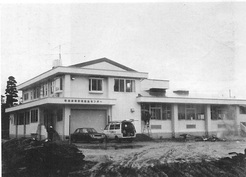
④ 給食センター新設
