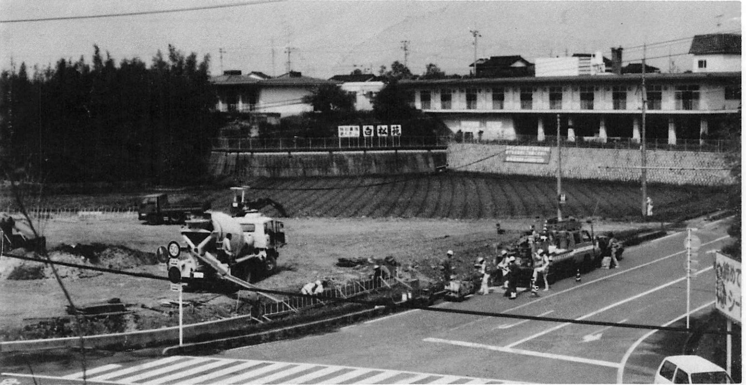
▲国道沿いは工事中
