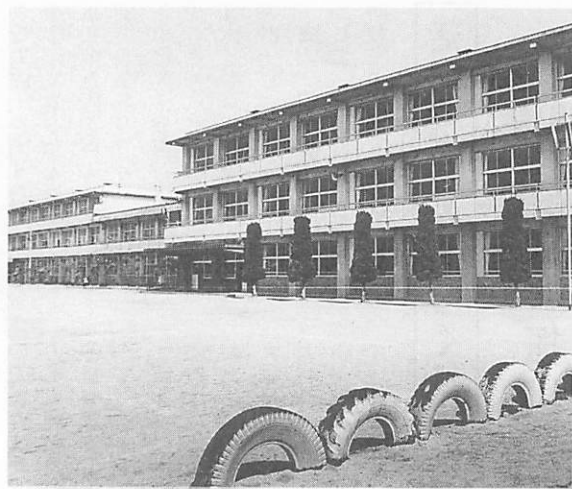
分離新設により過大規模校の解消を図る大内小学校。今年度造成工事に着手し、平成5年4月開校予定。
