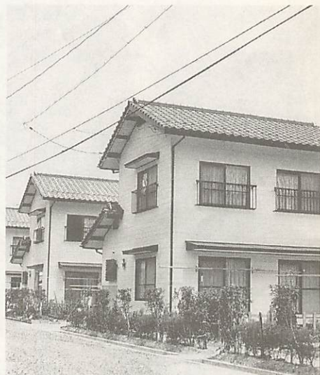
平成元年度に建設された8戸の鯖山市営住宅、2年度には4戸が建設されます。
