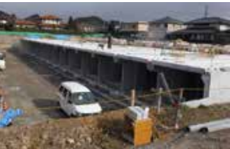
整備中の赤妻2号雨水貯留施設
