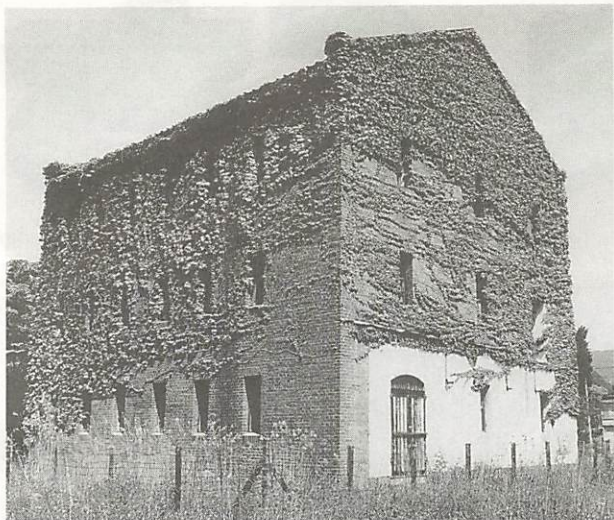
旧県立図書館書庫 敷地面積 4,014㎡ 建物延床面積 498㎡ 構造 組積(レンガ)造3階建
