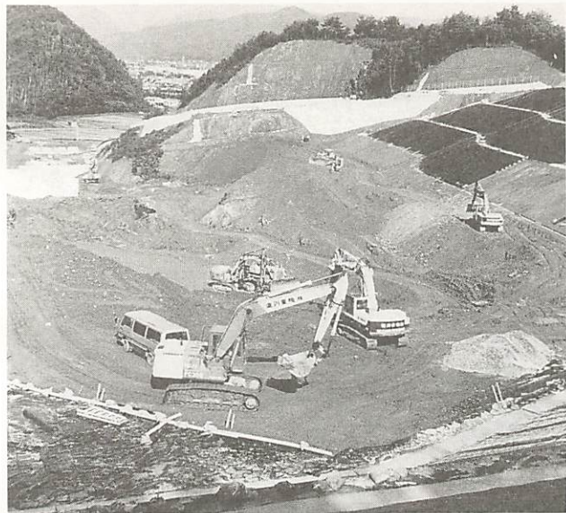
来年4月の使用開始を目指し、工事の進む大内神田不燃物最終処分場。容量は約34万㎡で、およそ10年間は処理できます。
