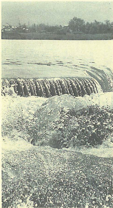
河川の危険箇所は、自然護岸で断面不足などによって、決壊やいっ水が予想されるところです(大内・氷上橋上流附近)
