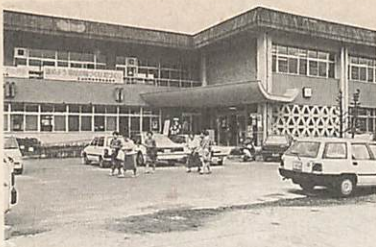
補修工事の行われる福祉センター
