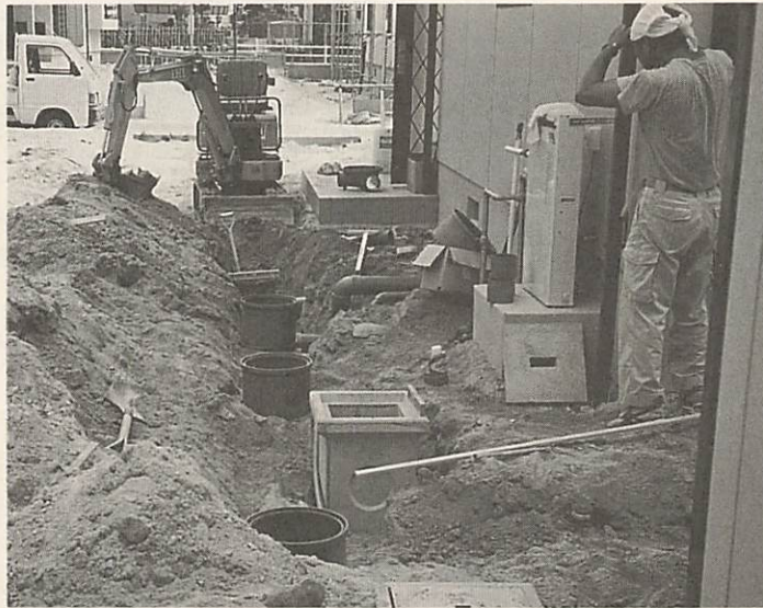
公共下水道に接続する家庭の排水設備工事
