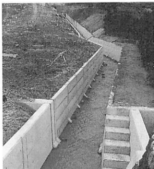
蔵場川改良工事
