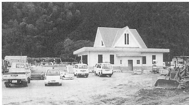
建設中の島地地区集排終末処理場
