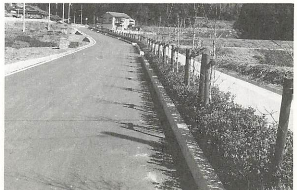
完成した薬師参道線
