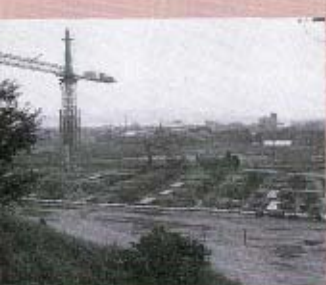
基礎躯体工事の様子
