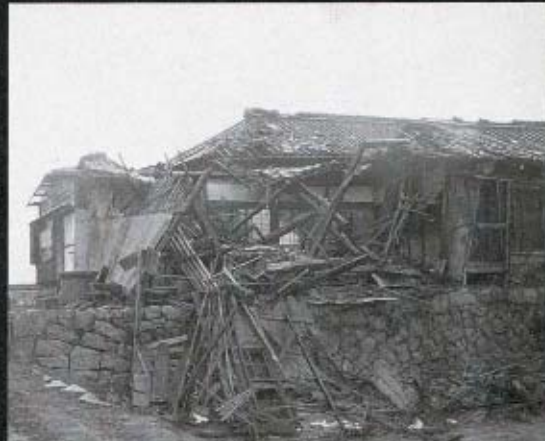
数多くの家屋が倒壊(黒湯南公民館)
