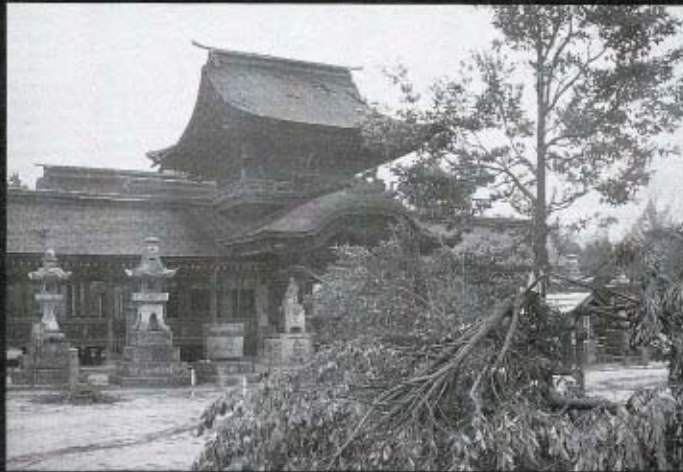
正八幡宮の檜皮がはがれるなど、文化財も大きな被害を被った
